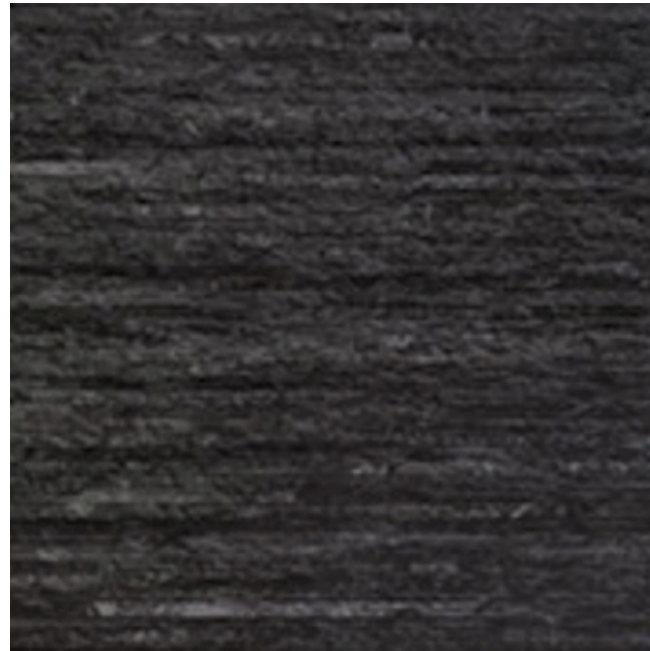
Muros de fachada
